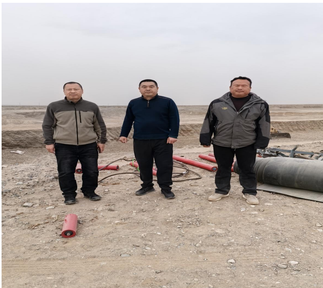
第一次现场勘验照片（左边为注册工程师韩振民，右边为项目负责人李显逵）
