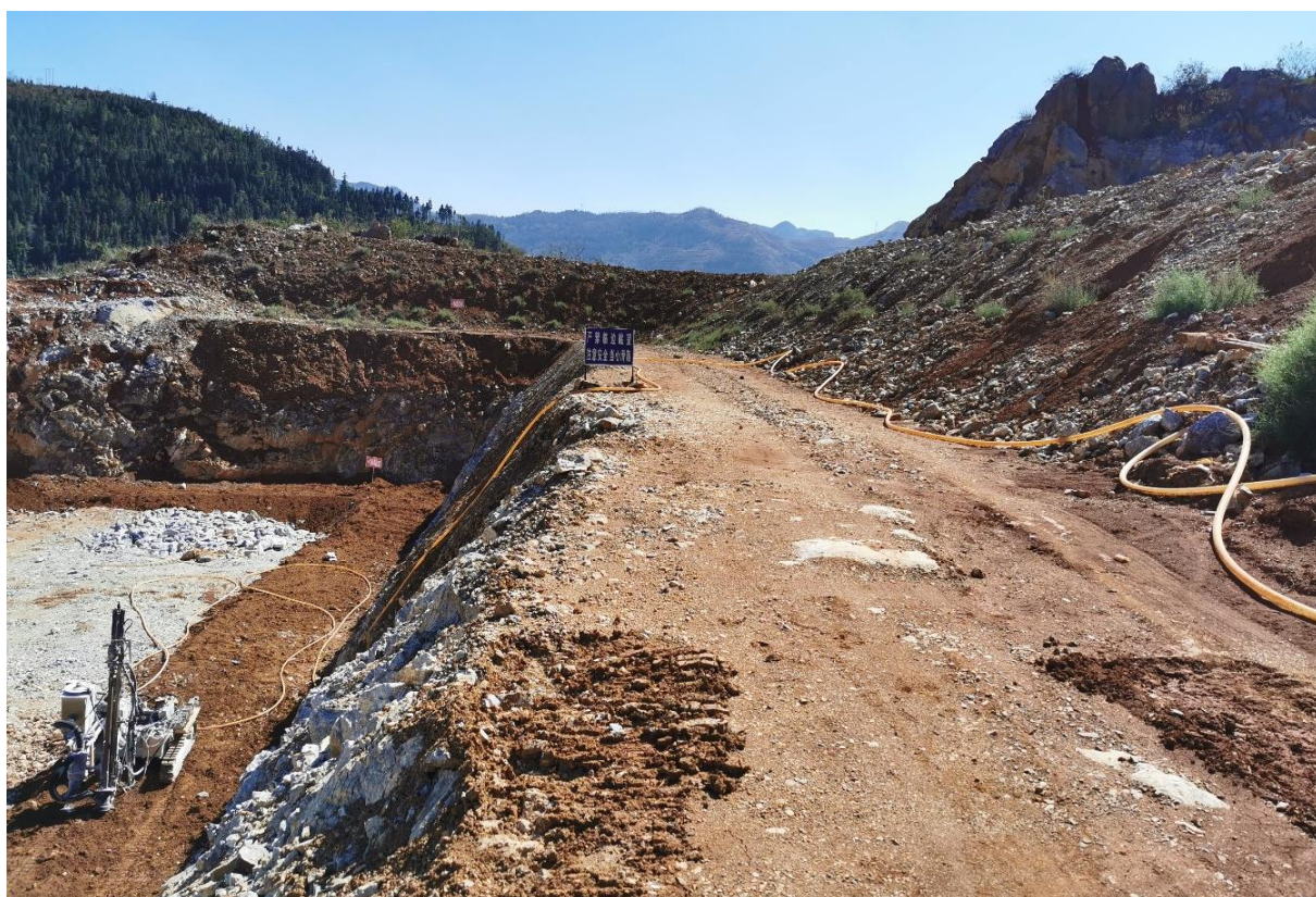
矿山已形成安全平台
