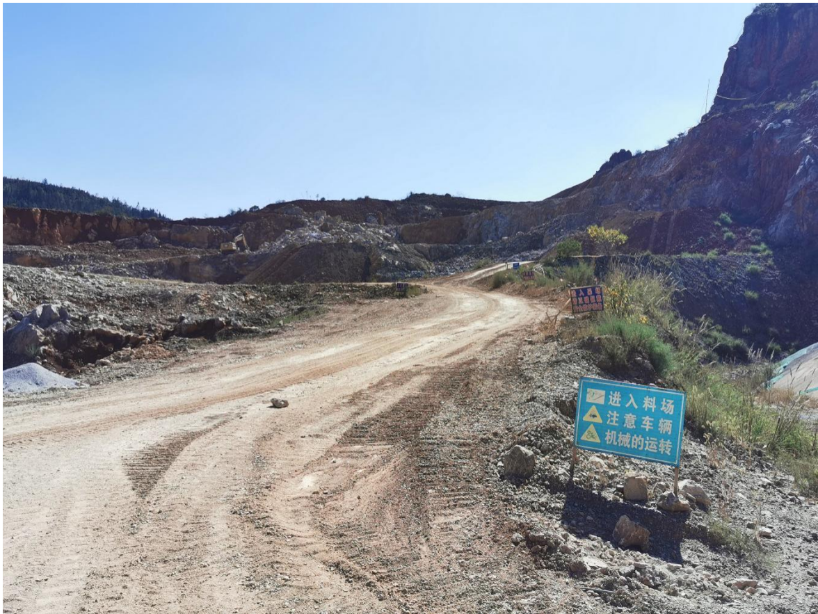
矿山运输公路
