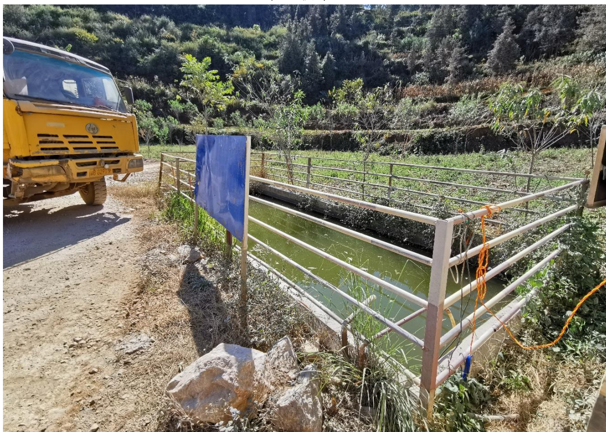
矿山消防水池
