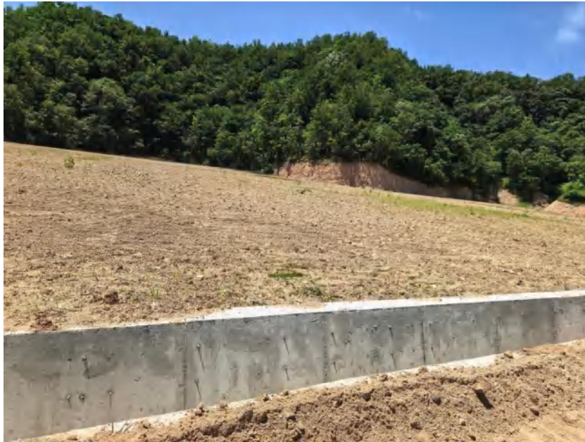
图11：新建堆积坝顶横向排水沟
