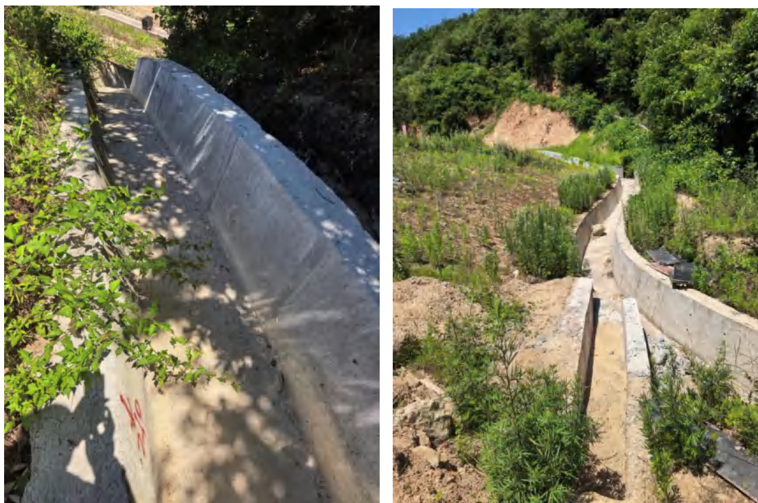
10. 新建右侧坝肩明渠
