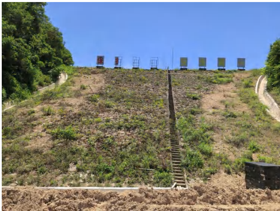
照片1 初期坝外坡
