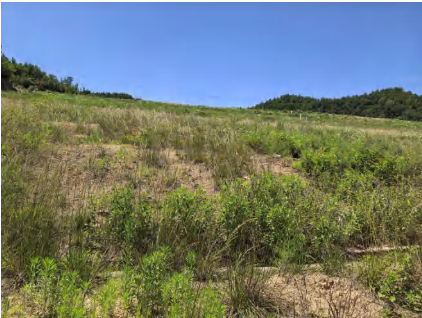
图片2 堆积坝外坡
