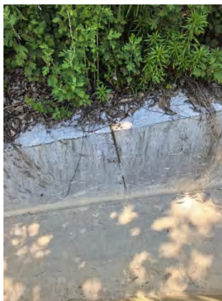
图15：明渠伸缩缝
