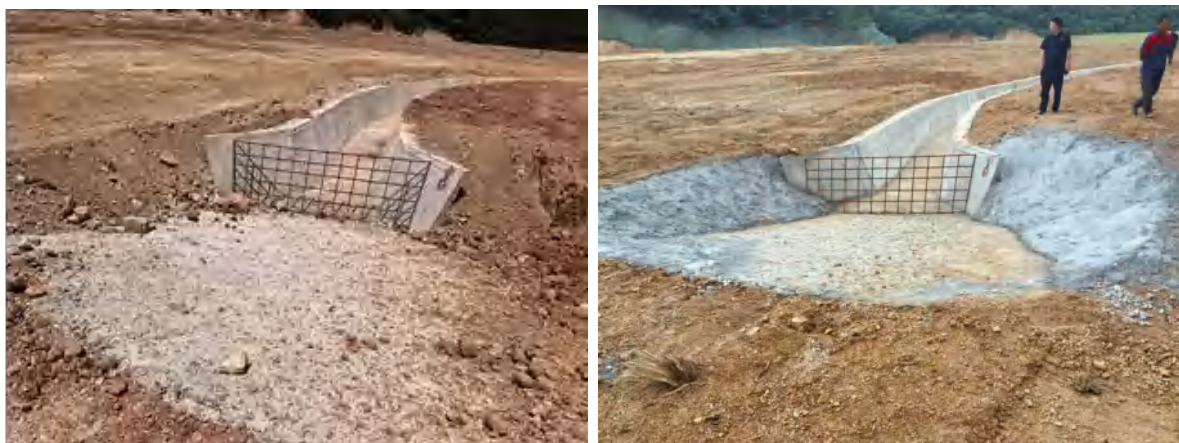
图7：排水明渠喇叭状进水口整改前及整改后对比照片
