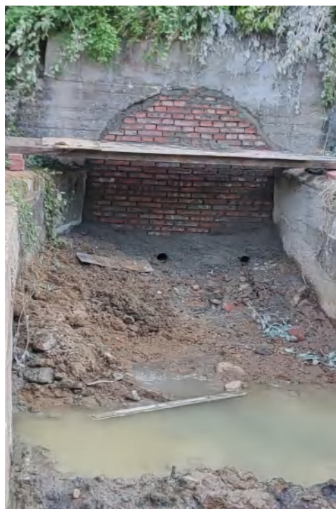
图5 封堵后的排洪隧洞出水口
