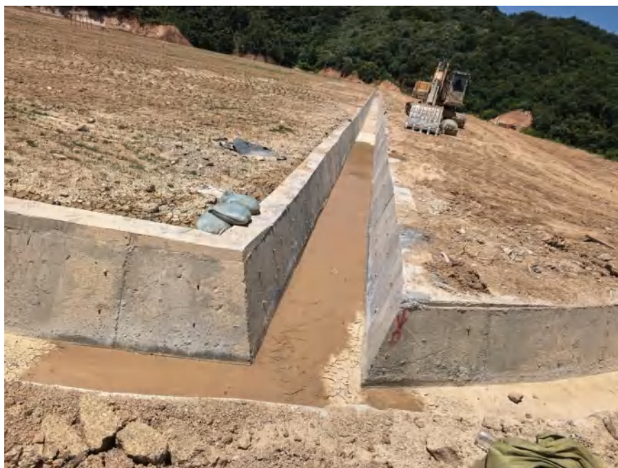
图12：新建滩面中部顶横向排水沟
