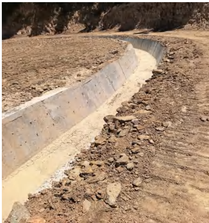
图6：滩面左侧排水明渠
