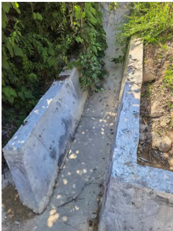
图8 左侧坝肩明渠出水口
