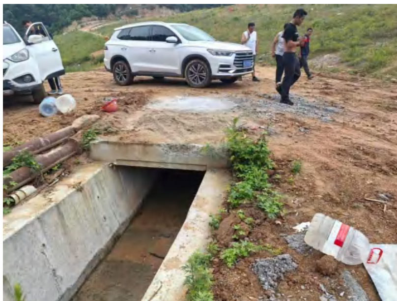
图14：第十一级子坝右侧明渠穿路段钢筋混凝土盖板
